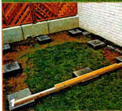
На бетонный цоколь укладывают тротуарные плиты, тщательно выверяя их по горизонтали и высоте.
