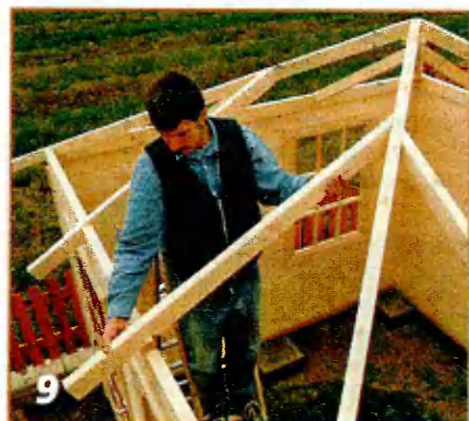
9 Более короткие стропила вставляют в вырезы верхних досок и крепят шурупами. Более длинные (укосные) стропила крепят к коньковому прогону посредством металлических накладок и шурупов.
