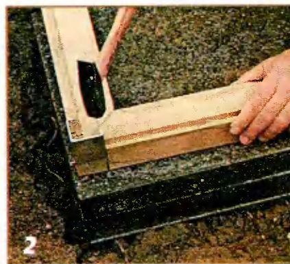
На бетонный цоколь укладывают тротуарные плиты, тщательно выверяя их по горизонтали и высоте.
