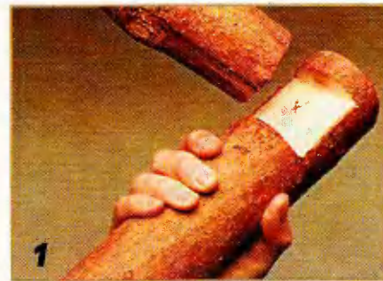
Врубка вполдерева повышает прочность обычных соединений на гвоздях.
