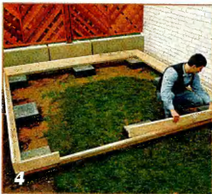
4 Подготовив нижнюю конструкцию, крепят первый ряд шпунтованных досок.
