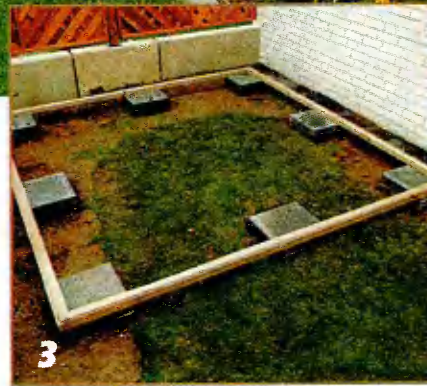
Выполнив два первых угловых соединения, выверяют остальные балки, пользуясь при этом уровнем большой длины и деревянными дистанционными прокладками.
