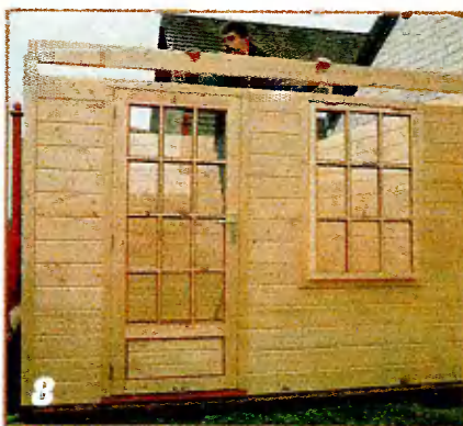
8 Над окнами и дверью монтируют по периметру последний ряд досок, снабженных сверху не гребнями, а вырезами под элементы стропильной конструкции.
