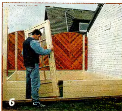
6 Закрепив первые три ряда шпунтованных досок, в оставленный проём устанавливают дверную коробку, которая вместе с дверным полотном образует единый дверной блок.
