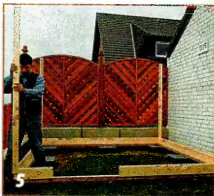
5 После крепления досок первого ряда устанавливают угловые стойки, которые просто вставляют сверху в пазы.
